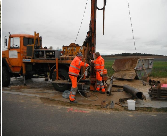
Anlage einer neuen Grundwassermessstelle im ersten Grundwasserleiter, Oktober 2018 bei Neukalen. (Foto: StALU MS)
