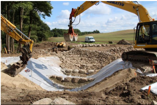
Bau einer Fischtreppe, Sommersdorfer Mühlbach (Foto: StALU MS)
