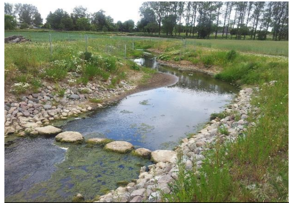
Fertige Renaturierung, Golmer Mühlbach (Foto: StALU MS)
