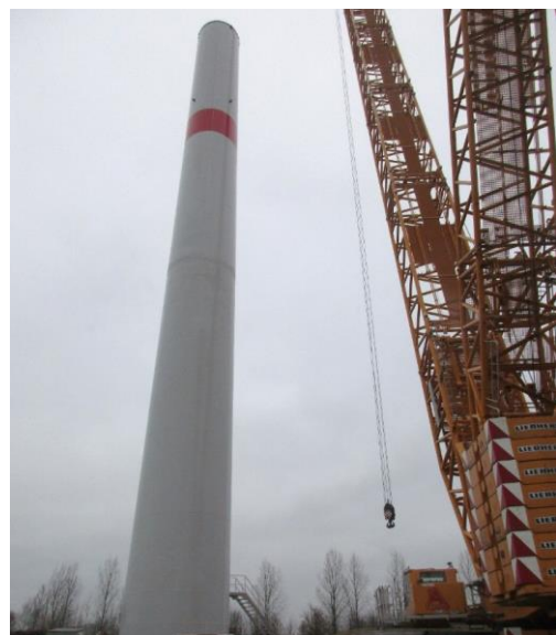
Errichtung einer Windkraftanlage nahe der Deponie Stern bei
