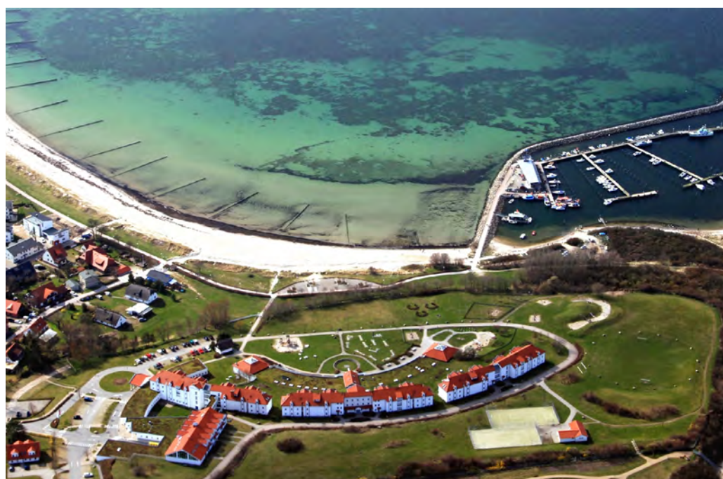
▲ Küstenschutzanlagen und Sportboothafen vor Glowe auf Rügen.
