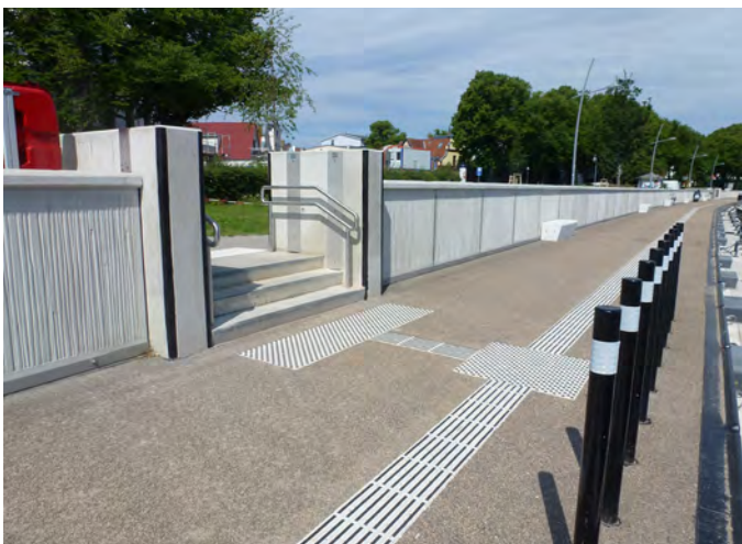
▲ Hochwasserschutzwand in Warnemünde.
