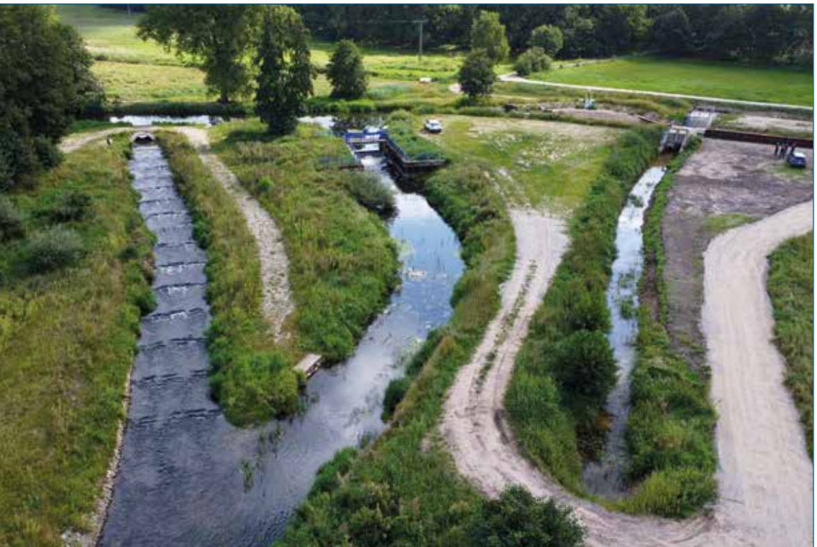
nachher: Rotenfurt mit Wehr und Fischaufstiegsanlage (Foto: StALU Westmecklenburg)
