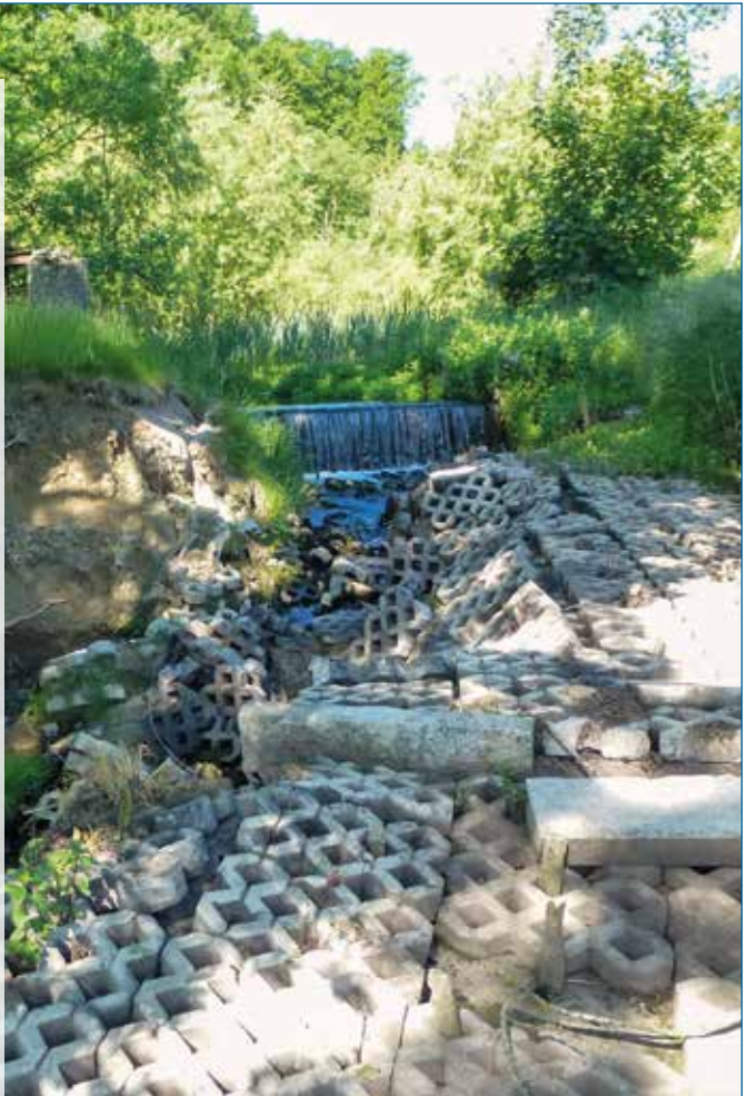
vorher: mit Rasengittersteinen ausgelegte Hochwasserentlastung und Mühlgraben (Foto: StALU Mittleres Mecklenburg)
