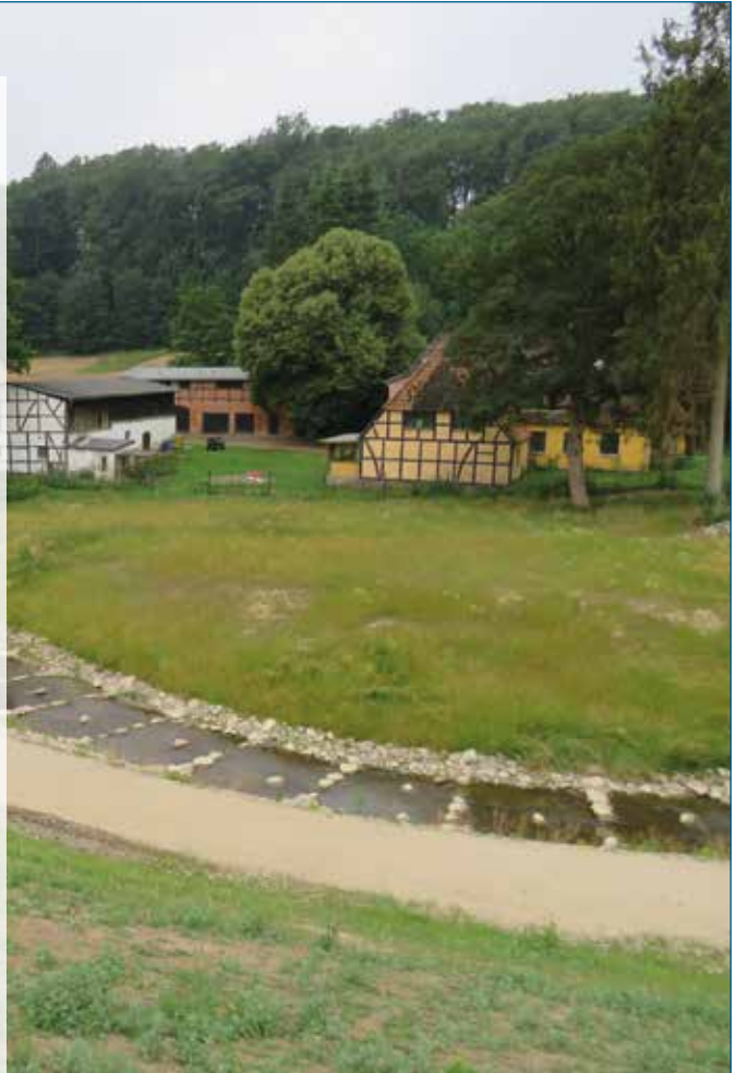
nachher: eine Fischaufstiegsanlage als Raugerinne-Beckenpass ersetzt die alte Hochwasserentlastungsstrecke (Foto: StALU Mittleres Mecklenburg)
