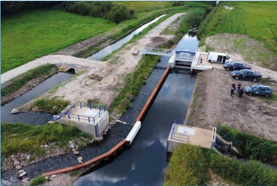
nachher: Sude mit Wehrneubau und Fischaufstiegsanlage (Foto: StALU Westmecklenburg)
