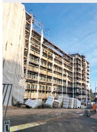
Beginn der Kernsanierung am Bestandsgebäude
