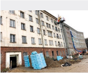
Fortgang der Kernsanierung
