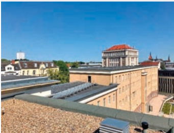
Blick vom Dach des LBZ nach Fertigstellung
