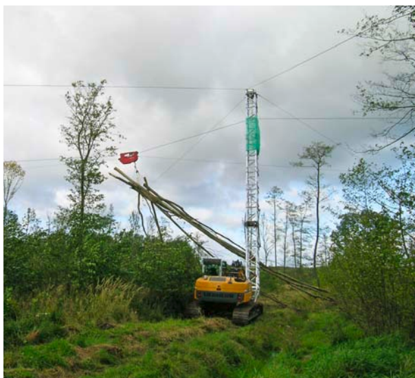
Abb. 17: Der Laufwagen passiert beim Vorrücken die von einem Trägerfahrzeug (Bagger) gehaltene Metallstütze. Diese künstliche Stütze ersetzt in geschädigten Beständen ausreichend standfeste Sattelbäume und dient der Zwischenabspannung.
