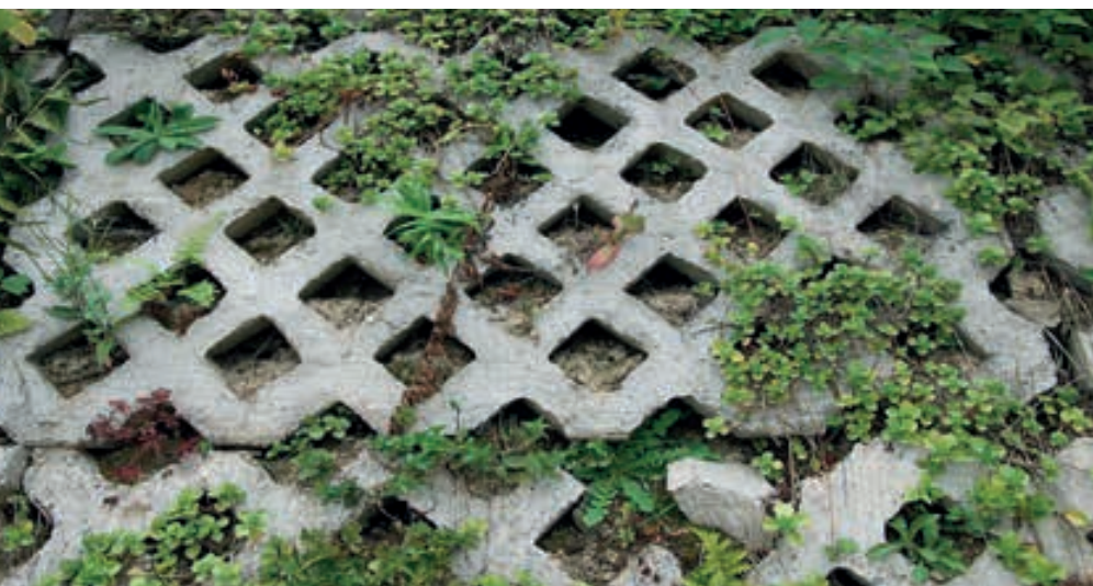
Durch die Verwendung teildurchlässiger Oberflächenbefestigungen können gering verschmutzte Flächen durchlässig für Niederschlagswasser gestaltet werden.
