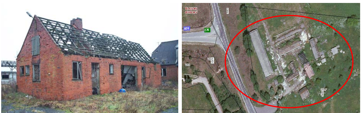
Abbildung 5 Verfallene Stallanlage im Außenbereich
