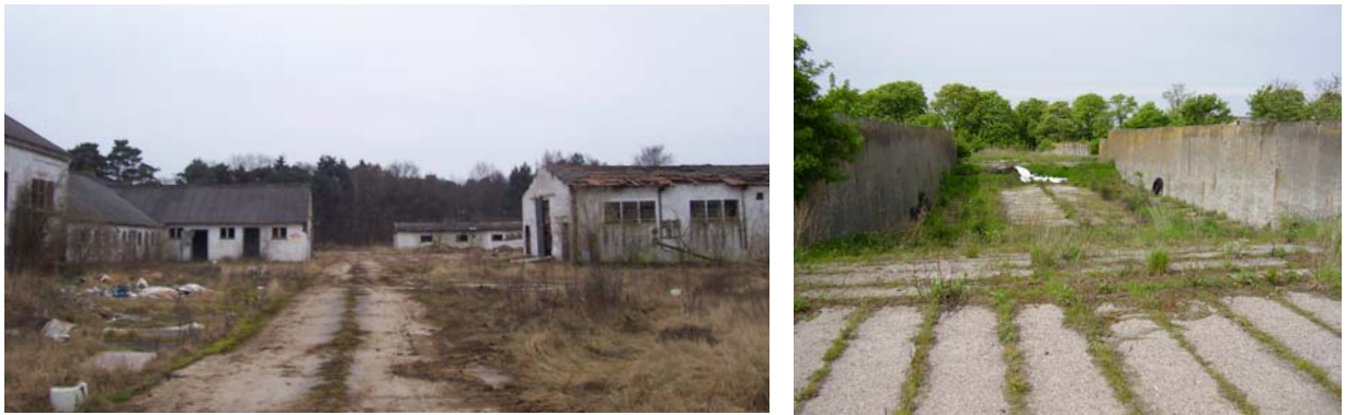
Abbildung 4: Ehemalige Milchviehanlage mit Verwaltungsgebäuden (links) und Altanlagenkomplex mit Klärgrube, Güllebecken und Silo (rechts)
