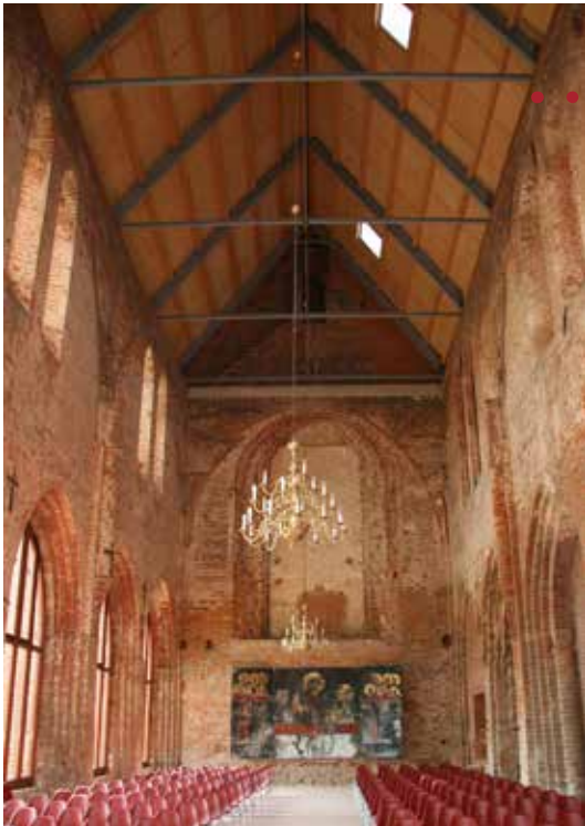
Kirchenschiff mit neuem Dach
