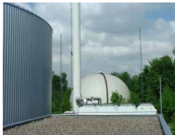
Abb. 7.5: Klärgas-Blockheizkraftwerk Bramow (Fertigstellung 1996)
