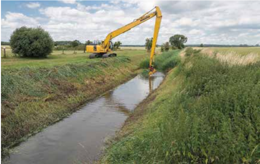
Abbildung 9: Maschinelle Krautung der Peene (Alt Sührkow, 06.07.2015) Foto: Torsten Ode
