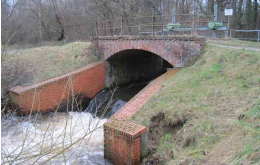
Abbildung 13: Massiver Sohlabschlag in der Sude bei Brömsenberg (2012) Foto: Martin Krappe
