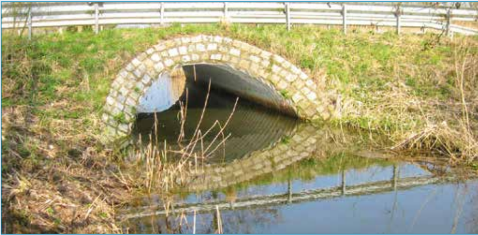
Durchlass an der Harkenbäk mit guter Anbindung an die Gewässersohle und natürlichem Strömungsverhalten; Foto: Pöyry ibs 2009
