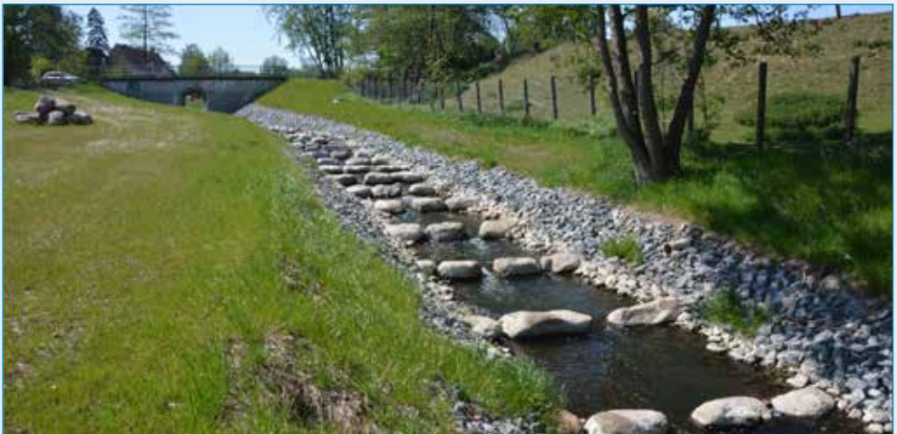
nach der Maßnahme: Abbau der Höhenunterschiedes über Riegel, Foto: StALU MS
