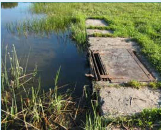
vorher: Auslaufbereich des Pelsiner Sees mit Stau; Abbildung: StALU VP
