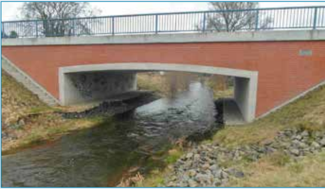
vorher: Sohlabsturz und massive Rampe (bereits abgebrochen) unter der Brücke; Foto: D. Podßun 2012
