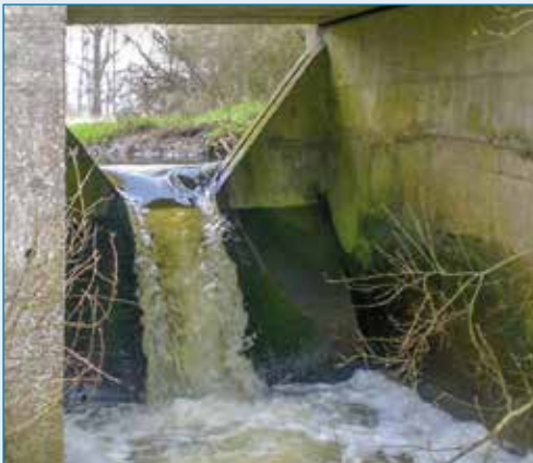
Sohlenabsturz am Poischower Mühlenbach; Foto: Institut biota GmbH 2008
