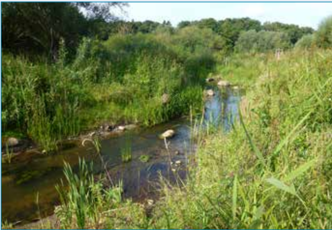
nachher: durchwanderbare neue Straßenbrücke an der B110 und neuer Gewässerlauf; Foto: Institut biota GmbH und StALU MM
