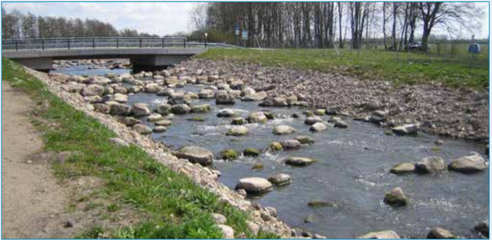
Naturnah gestaltetes Raugerinne in der Nebel bei Lüssow; Foto: StALU MM
