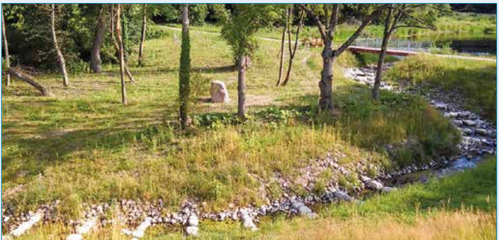
nach der Maßnahme: Ersatzneubau Raugerinne-Beckenpass, Foto: StALU VP 2015
