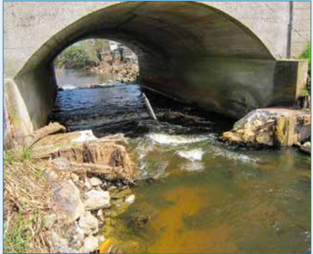
vorher: Sohlabsturz und massive Rampe (bereits abgebrochen) unter der Brücke; Foto: D. Podßun 2012
