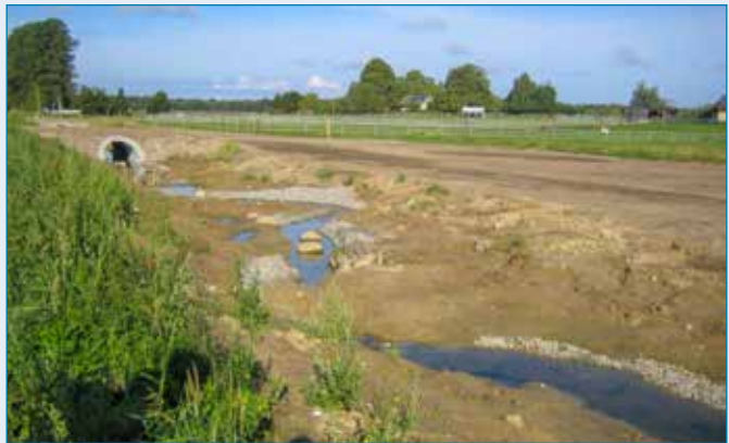
nach der Maßnahme: neu profilierter Abschnitt des Radelbaches, im Hintergrund: Ersatzneubau eines Durchlasses mit größerem Profil, Foto: StALU MM 2015
