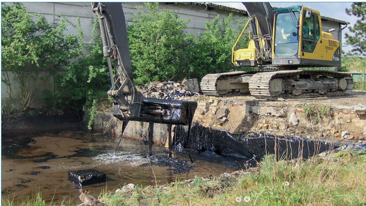
Abbildung 55: Bodenaushub an der ehemaligen Tankstelle Bad Doberan (94)
