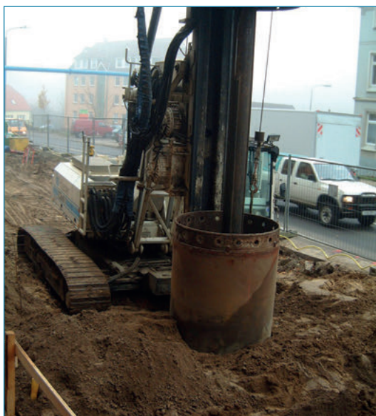
Abbildung 56: Altlastensanierung durch Großlochbohrung an einer ehemaligen Tankstelle in Bad Doberan (94)
