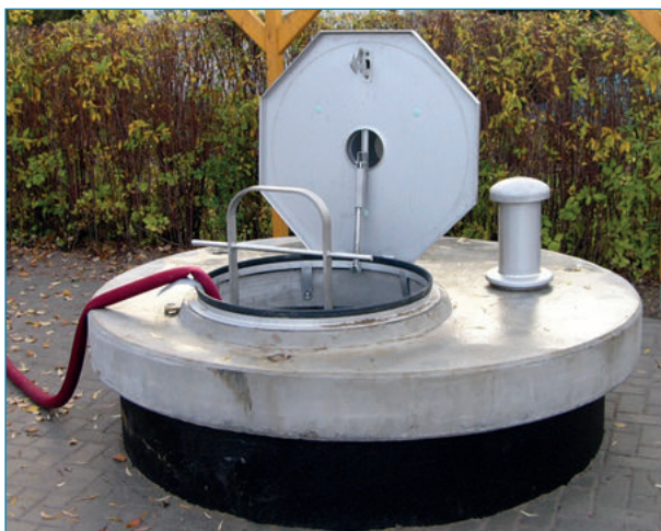
Abbildung 17: Notwasserbrunnen in Rostock (39)
