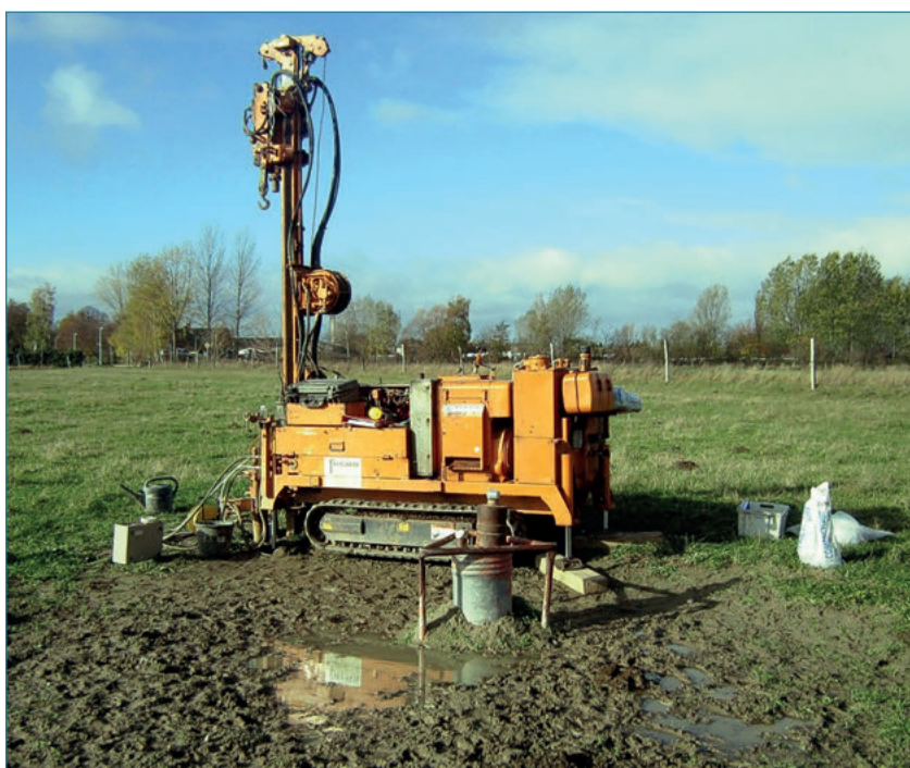
Abbildung 45: Bohrgerät am Standort Schwerin Süd (9)
