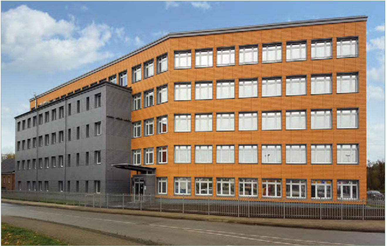
Sanierte Außenfassade des LALLF Neubrandenburg (Quelle: SBL 2019)
