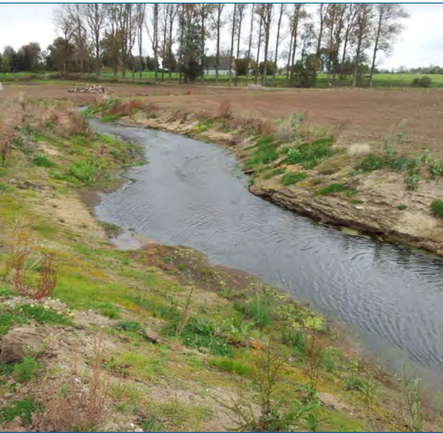
nachher: 2011 Entrohrung und naturnahe Gestaltung – unmittelbar nach Baumaßnahme (Foto: StALU Mecklenburgische Seenplatte)
