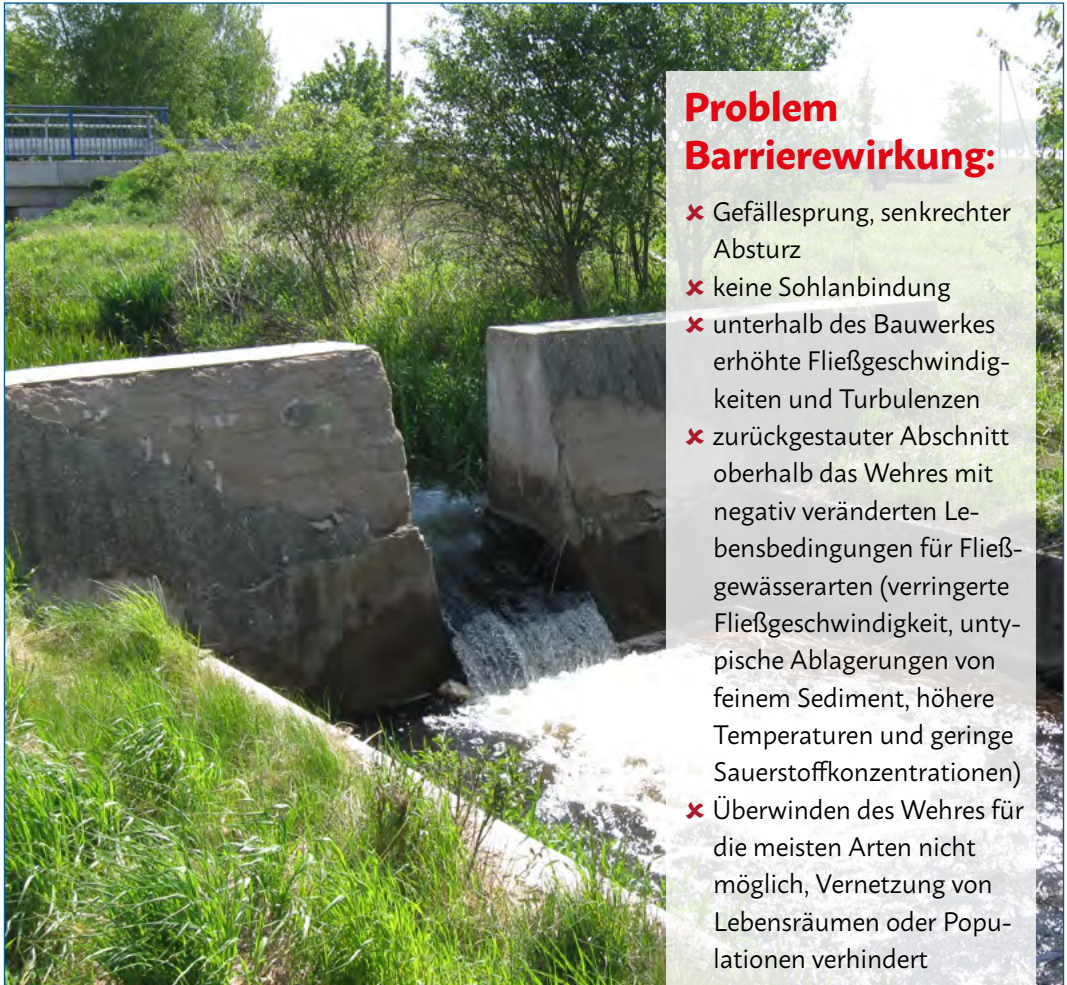
vorher: festes Wehr mit Absturz und Tosbecken (Foto: StALU Westmecklenburg)
