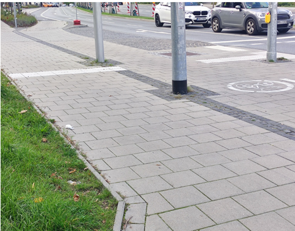
Abb. V 21 – Trennung Geh-/Radweg durch kontrastierten, taktilen Trennstreifen aus Kleinpflaster
