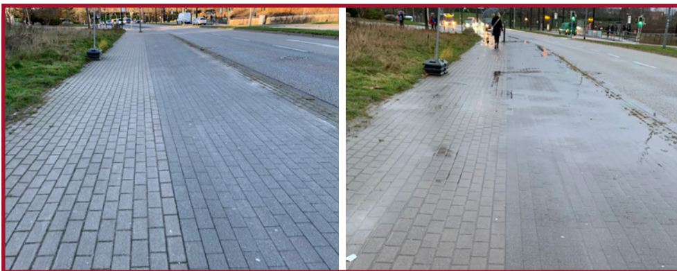
Abb. III 2 – Beispiel für Aufhebung eines scheinbaren Kontrastes bei Nässe
