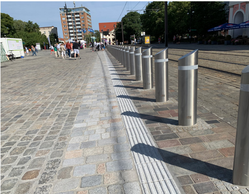
Abb. V 17 – Platz mit Großpflasterbefestigung, Gehbahn aus geschnitte- nem Großpflaster, einseitig begrenzt mit kontrastierter Rippenplatte als Leitlinie zu einer Straßenbahn- haltestelle
