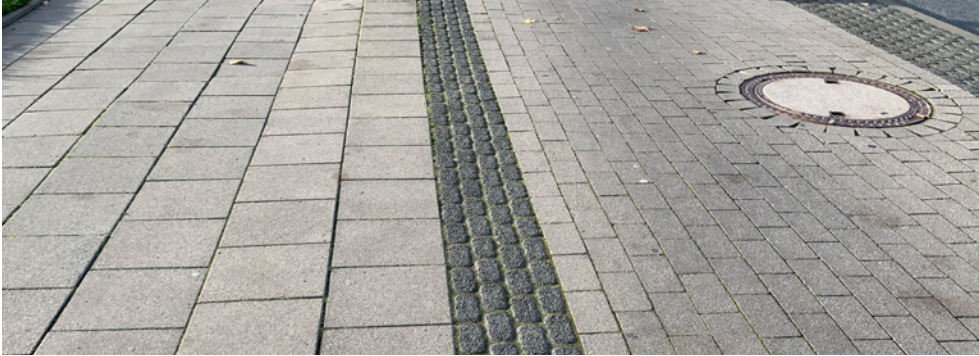
Abb. II 18 – Begrenzungsstreifen aus Pflaster mit kontrastierender und taktiler Wirkung zwischen Gehweg (links) und Radweg (rechts)
