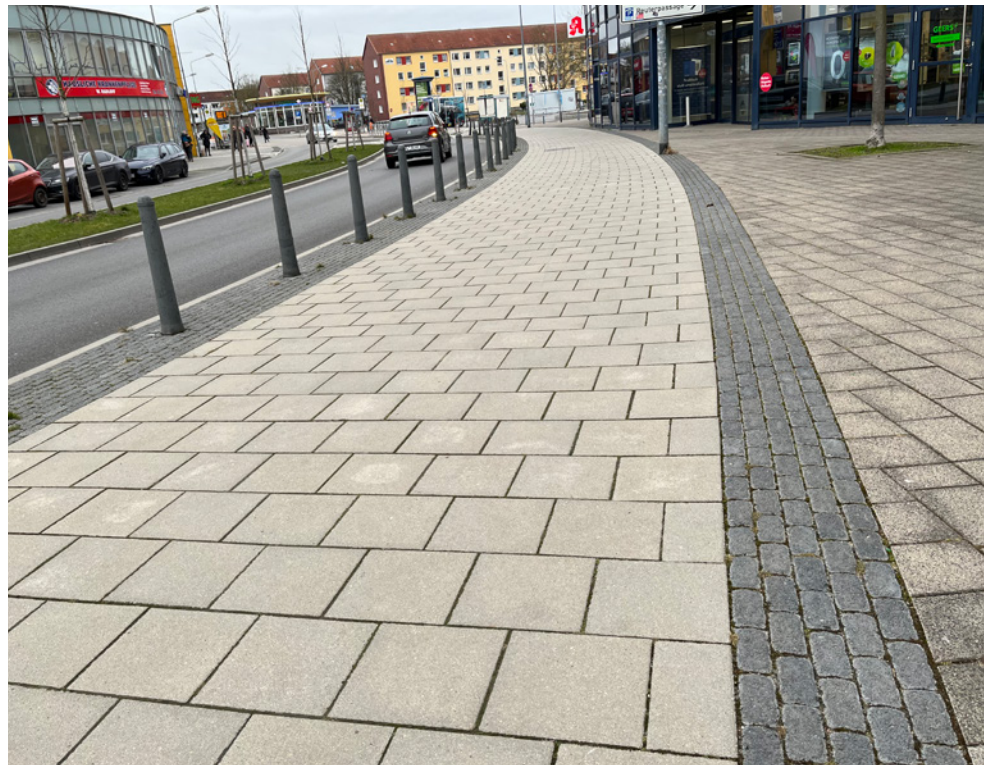
Abb. V 18 – Abgrenzung Gehbereich zum Seitenraum mit kontrastreichem, taktil ertastbarem Begrenzungs- streifen
