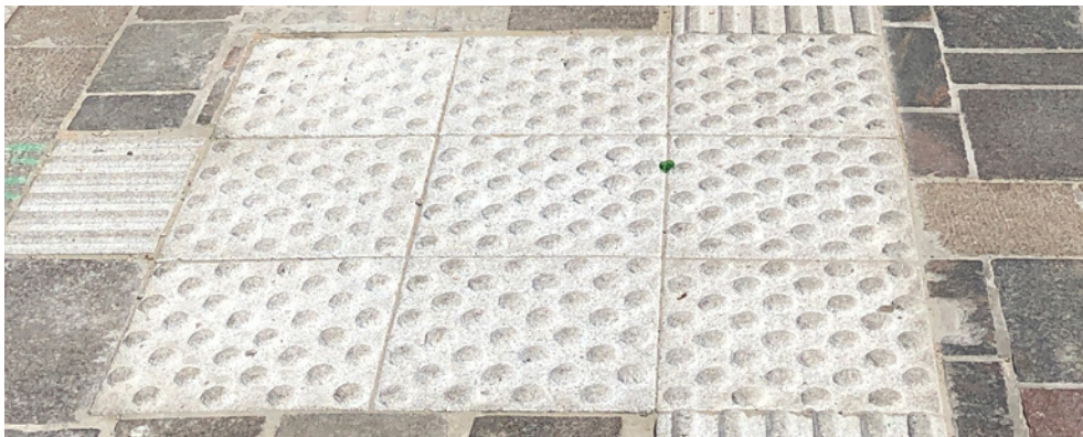
Abb. II 34 – diagonale Anordnung der Noppens- struktur auf Noppenplatten
