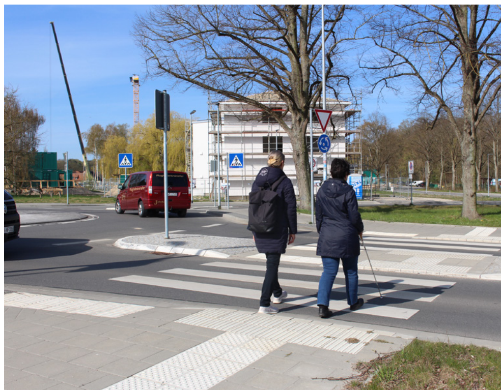
Abb. V 32 – gesicherte getrennte Querung mit Mittelinsel (FGÜ) im Bereich eines Kreisverkehrs
