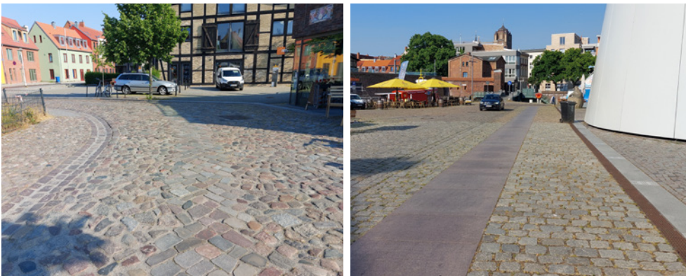
Abb. III 1 – Beispiele für Oberflächen aus Natursteinpflaster und -platten
