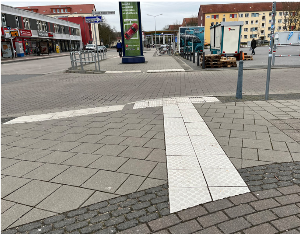
Abb. V 3 – ungesicherte getrennte Querung sowie Straßenausstattung
