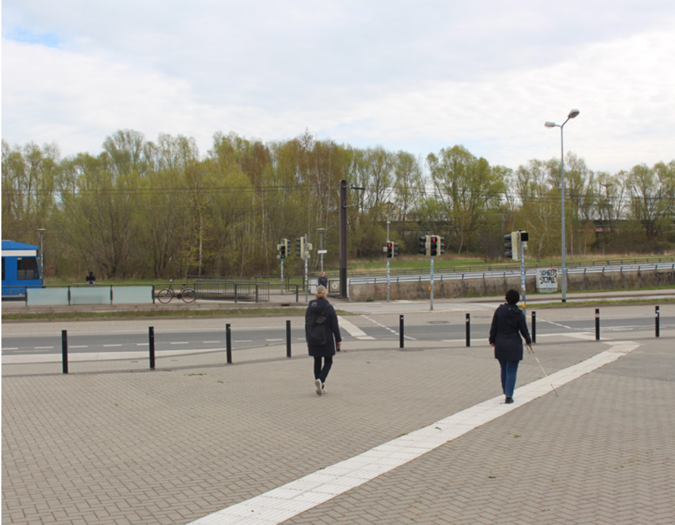
Abb. V 29 – Leitstreifen zu einer gesicherten Querung
