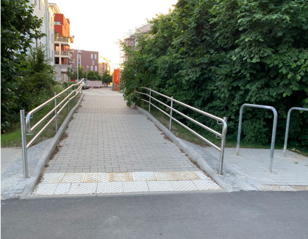
Abb. V 10 – Rampe mit farbigem Podest und Geländer
