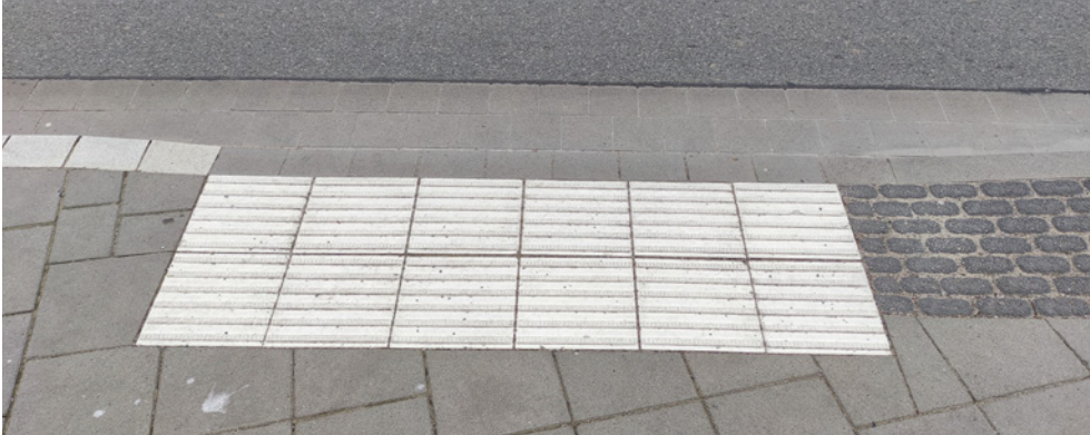
Abb. II 27 – Rippenplatten vor Querungsstelle mit Nullabsenkung (Sperrfeld)
