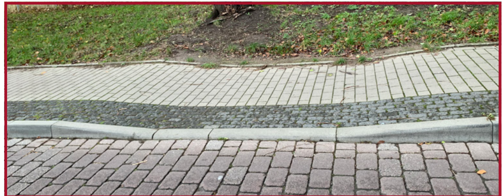
Abb. II 10 – zu vermeidende Absenkung über gesamte Gehwegbreite
