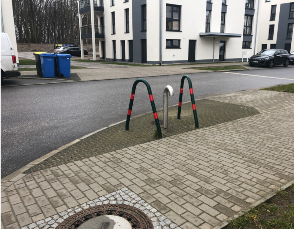
Abb. V 24 – Ausstattung im Bereich einer Wohngebietserschließung in kontrastierter, taktiler Flächenbefestigung
