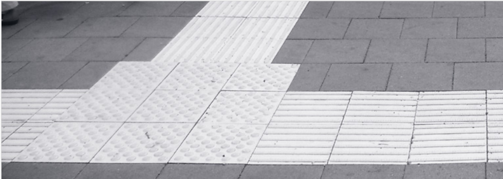
Abb. II 38 – Abzweigfeld an Ab- oder Verzweigungen von Leitstreifen
