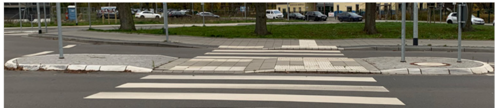
Abb. II 14 – Querungshilfe mit geteilter Absenkung über gesamter Breite
