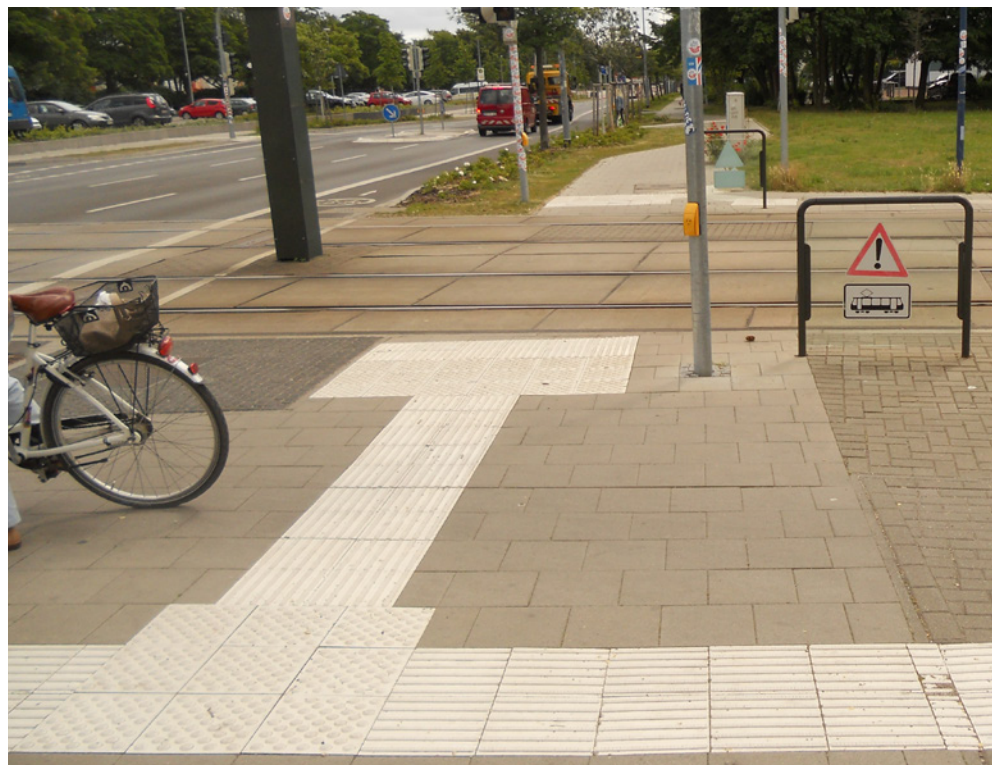
Abb. V 14 – Querung Straßenbahntrasse unbe- schränkt, gesichert
