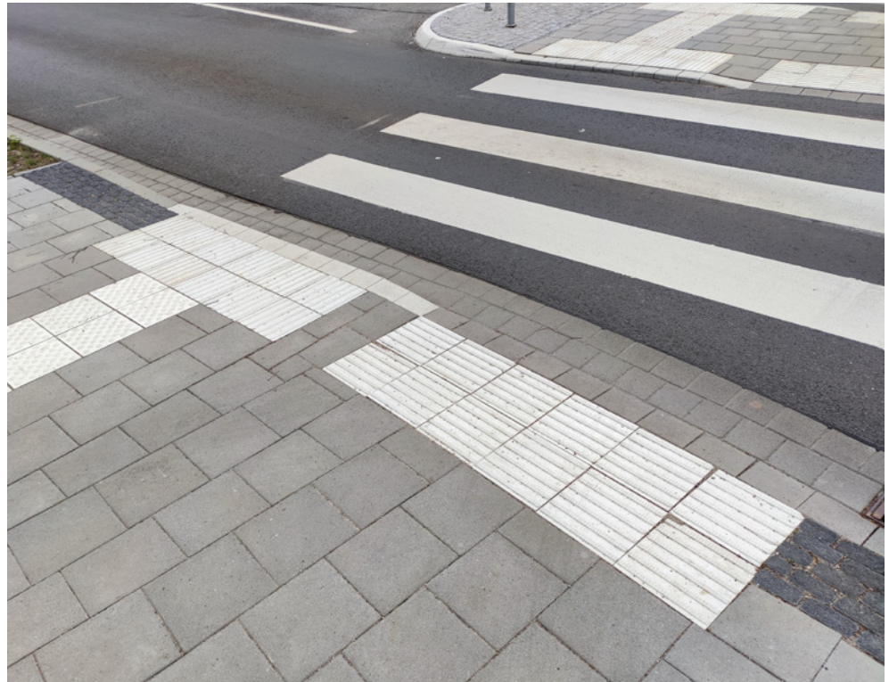
Abb. V 4 – gesicherte getrennte Querung mit Mittelinsel
