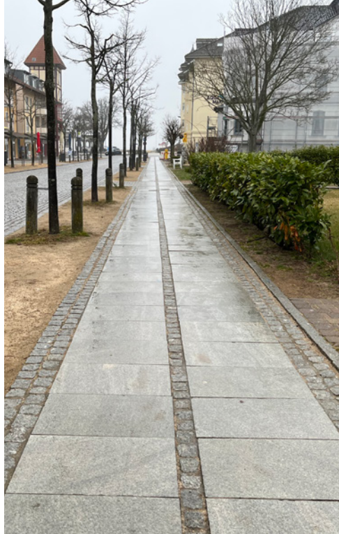
links: Abb. V 15 – Gehbahn mit Begrenzungsstreifen
