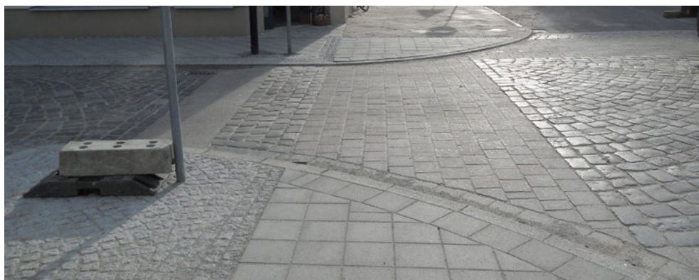
Abb. V 27 – innerörtliche Gehwegbefestigung mit Querung einer Anbindung vor denkmalpflegerischem Hintergrund
