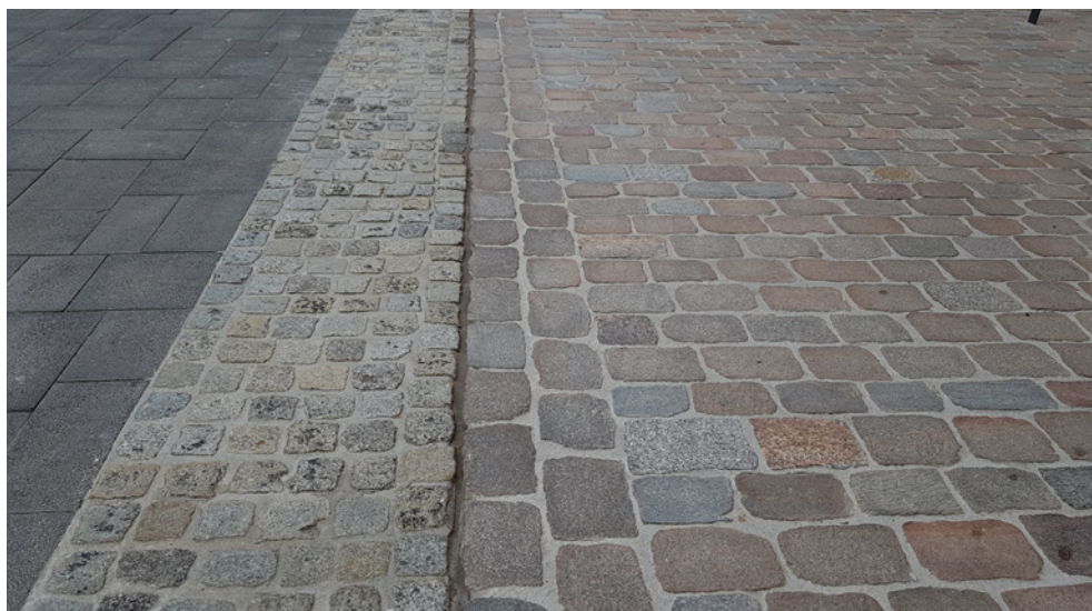
Abb. V 28 – geschnittenes Natursteinpflaster mit flach vergossener Fuge
