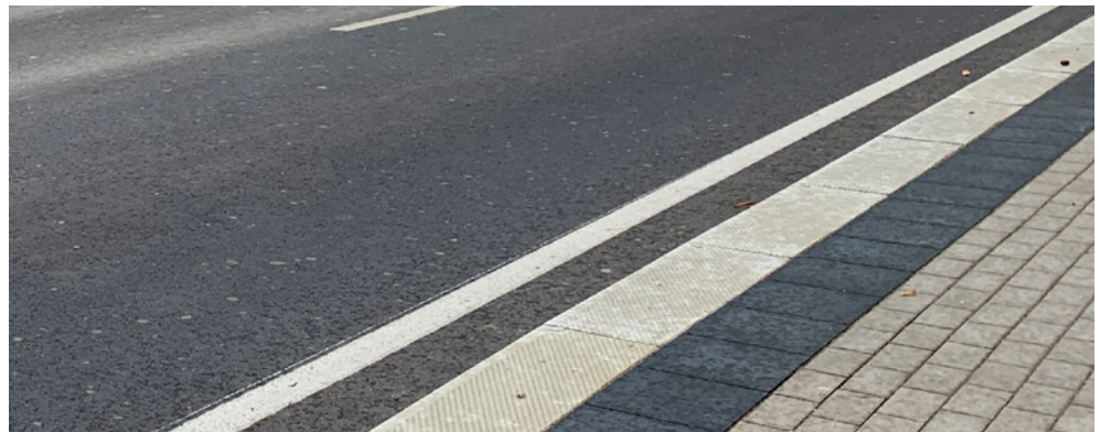
Abb. II 43 – Leuchtdichte- kontrast Hell-Dunkel (z. B. Weiß auf Grau) K > 0,40 = Kontrast; K > 0,70 = starker Kontrast
