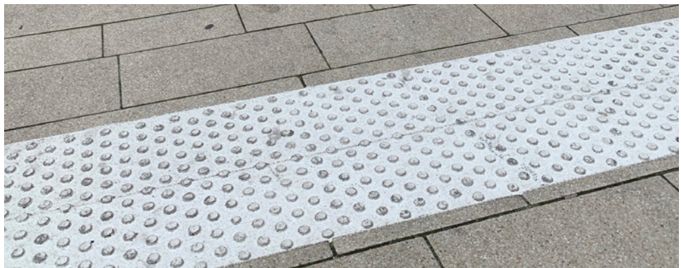
Abb. II 41 – nachträglich aufgetragene thermoplastische Markierung
