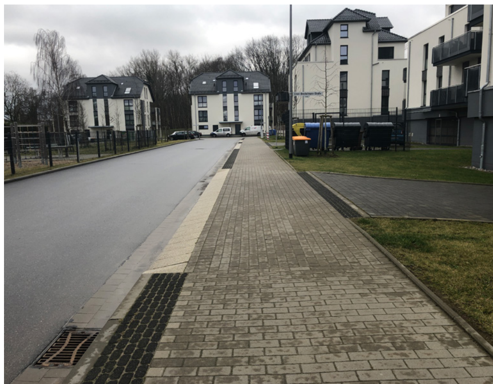
Abb. V 19 – Erschließungs- straße mit Zufahrten (Zufahrtenstein)
