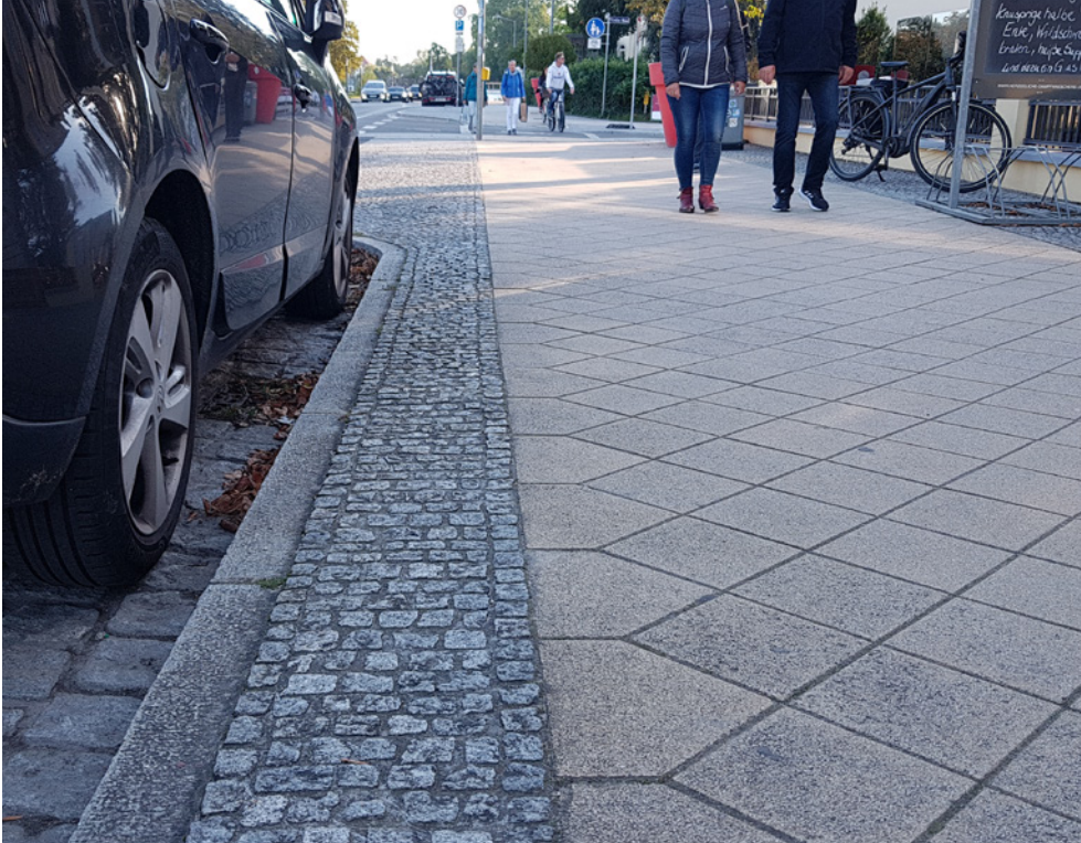
Abb. V 20 – Gehbahn, beidseitige Einfassung mit gut kontrastiertem Kleinpflaster
