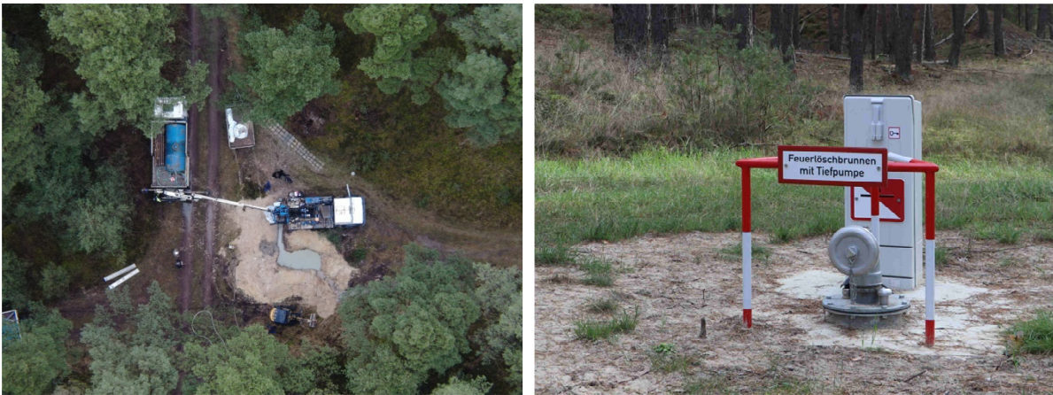
Abb. 46: Bau eines Feuerlöschbrunnens (links) und fertiggestellter Brunnen mit Tiefpumpe am Waldbrandriegel des Forstamts Kaliß (rechts) (Fotos: THOR).
