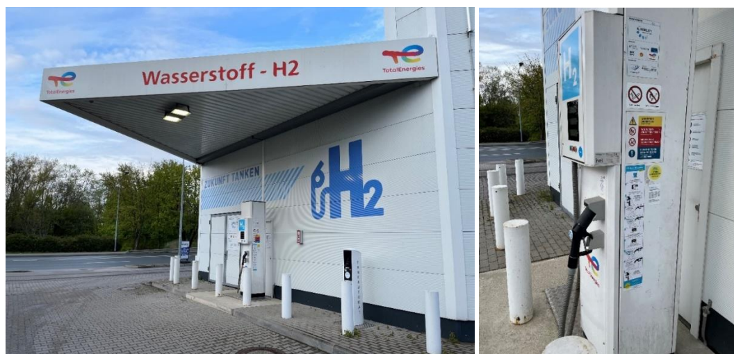
Abbildung 5: HRS der Firma Total / H2Mobility für Pkw am Standort Rostock (Tessener Str. 98) – Tankstelle heute nicht mehr in Betrieb (Bild: LBST).
