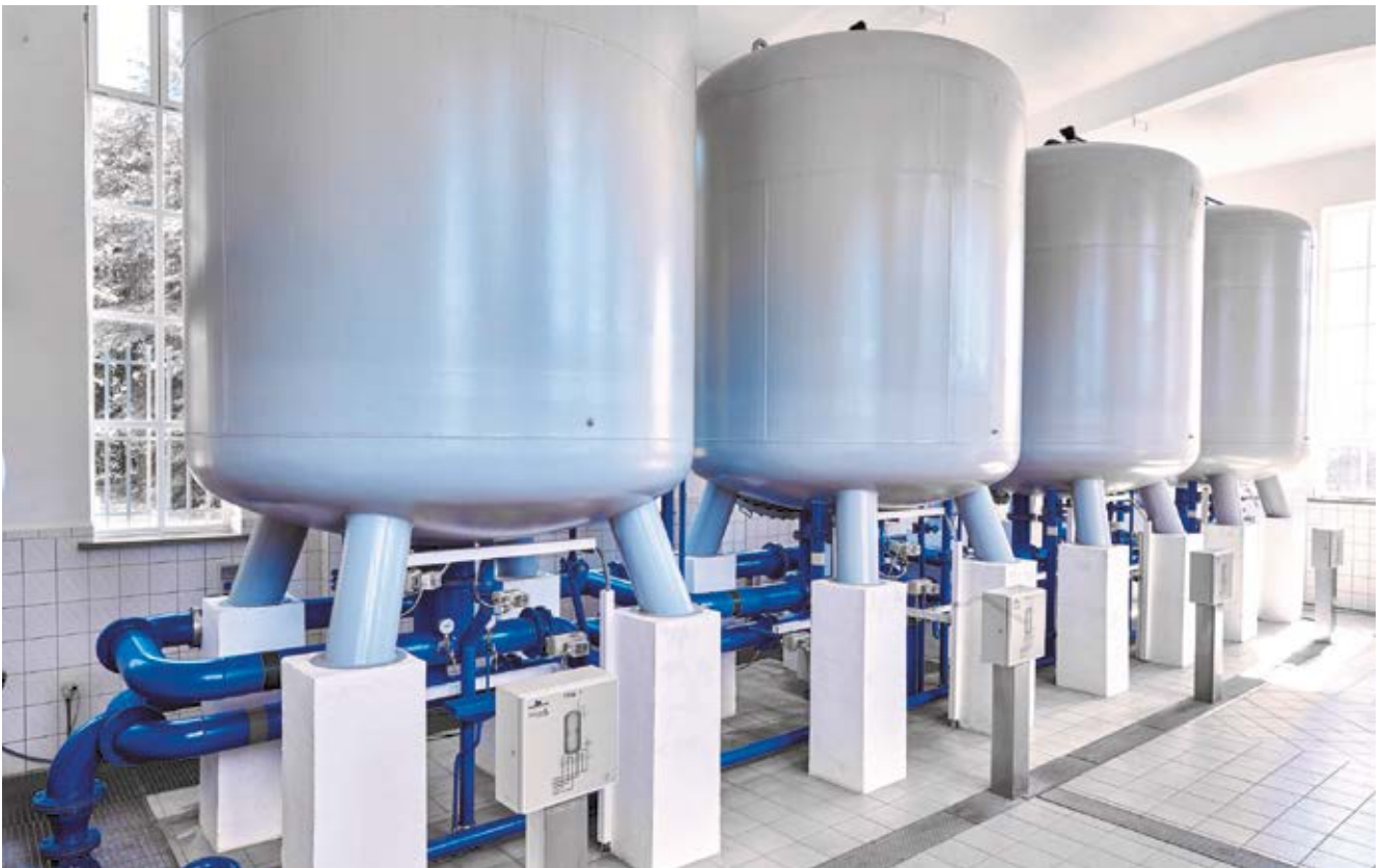
Abbildung 2: Filter im Wasserwerk Güstrow
