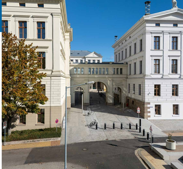
Daniels Bau ist von Anfang an mit dem Regierunqsgebäude I im 1. Obergeschoss über eine Brücke, den sogenannten „gedeckten Behördengang“, verbunden. Er schuf damit eine Portal-Situation von der Schloßstraße zur Graf-Schack-Allee.
