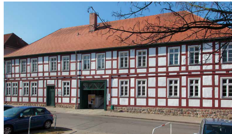
Den Schwerpunkt 2014 bildete das Thema „Friderizianische Kolonisation“, hier das Beispiel Pasewalk, Lkr. Vorpommern-Greifswald, Grünstraße 59, Fachwerkgebäude © LAKD M-V/LD, Achim Bötterf
