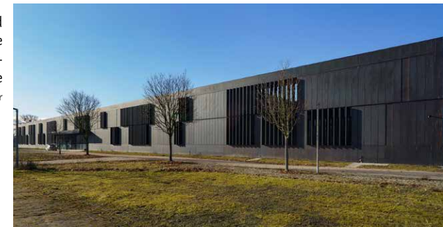
Depot- und Werkstattgebäude in der Johannes- Stelling-Straße © Achim Bötefür
