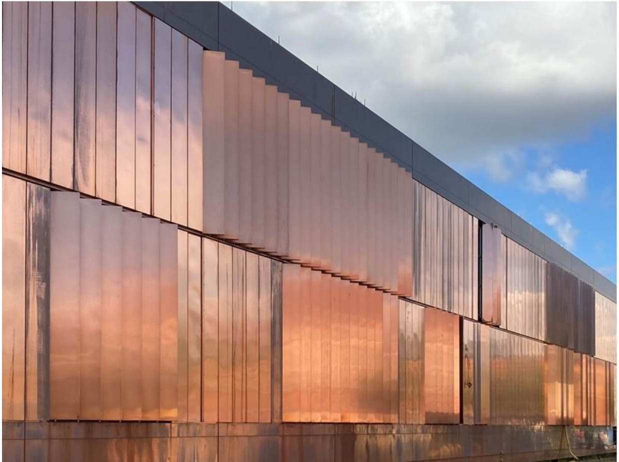
Depot- und Werkstattneubau | Schwerin https://ibpm-online.de/referenzen/47-dws-schwerin.html
