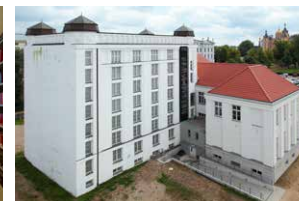
Der hohe Magazinbau von Westen
