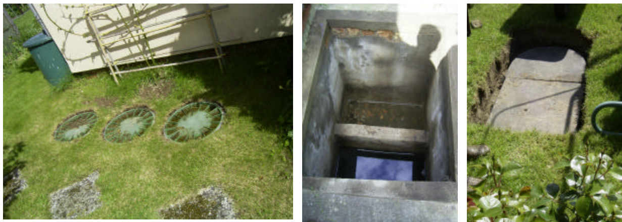
Bild 4: Beispiele von Mehr-Kammer-Gruben in Kleingärten (links 3 Fässer-Anlage ; Mitte selbst gemauerte „2-Kammer“-Anlage; rechts Deckel von WBK-Anlage)
